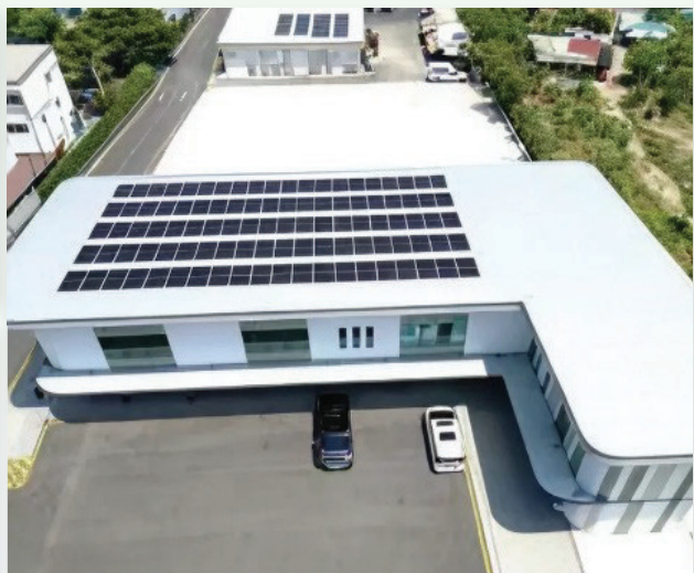
โครงการ Solar Rooftop (Ongrid)
